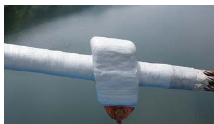
防食施工後ケーブルバンド
