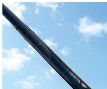
グラウト再充てん・保護管復旧
