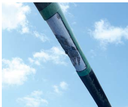
部分開封、グラウト材撤去
