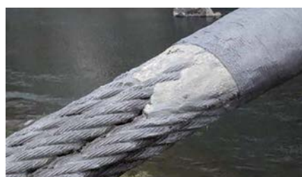
ケーブル一般部防食施工状況
