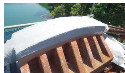
防食施工後サドル
