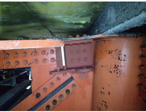
トラス梁への適用事例（屋根）
