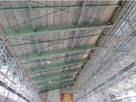
足場の設置状況（屋根、長尺配置）
