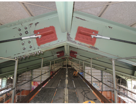
梁頂部の定着金具（屋根）
