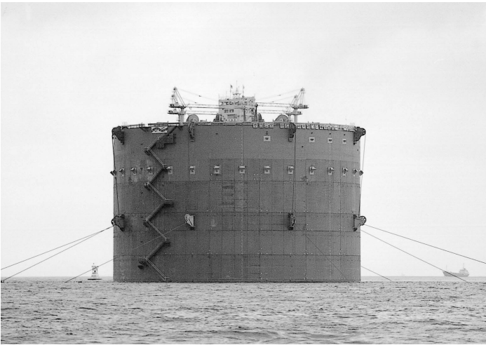
明石海峡大橋主塔用鋼ケーソンに係留するデルタフィラー®ロープ120mm
