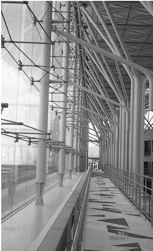
ガラス架構を支持するステンレスロープ
