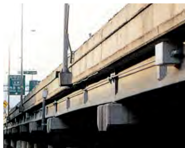
補強用外ケーブル external cables
