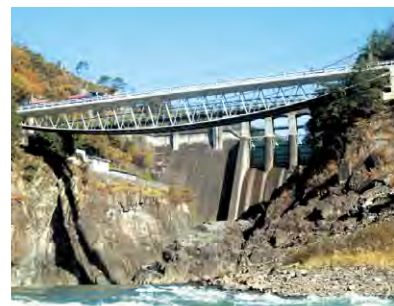
吊床版用ケーブル stress-ribbon bridge
