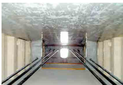
桁内外ケーブル external cables in Box girder
