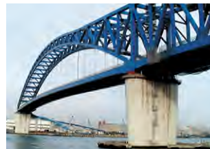
千歳橋(大阪市大正区) Chitose Bridge (Osaka)
