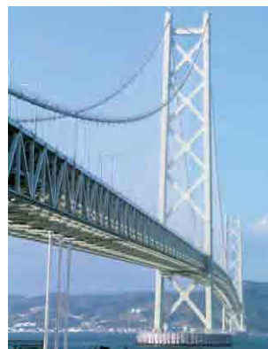
明石海峡大橋 (ハンガーケーブルに使用、 兵庫県神戸市～淡路町) Akashikaiyo Bridge (Hyogo)
