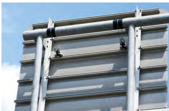
フェイルセーフ(標識用) Fail-safe (for signs)
